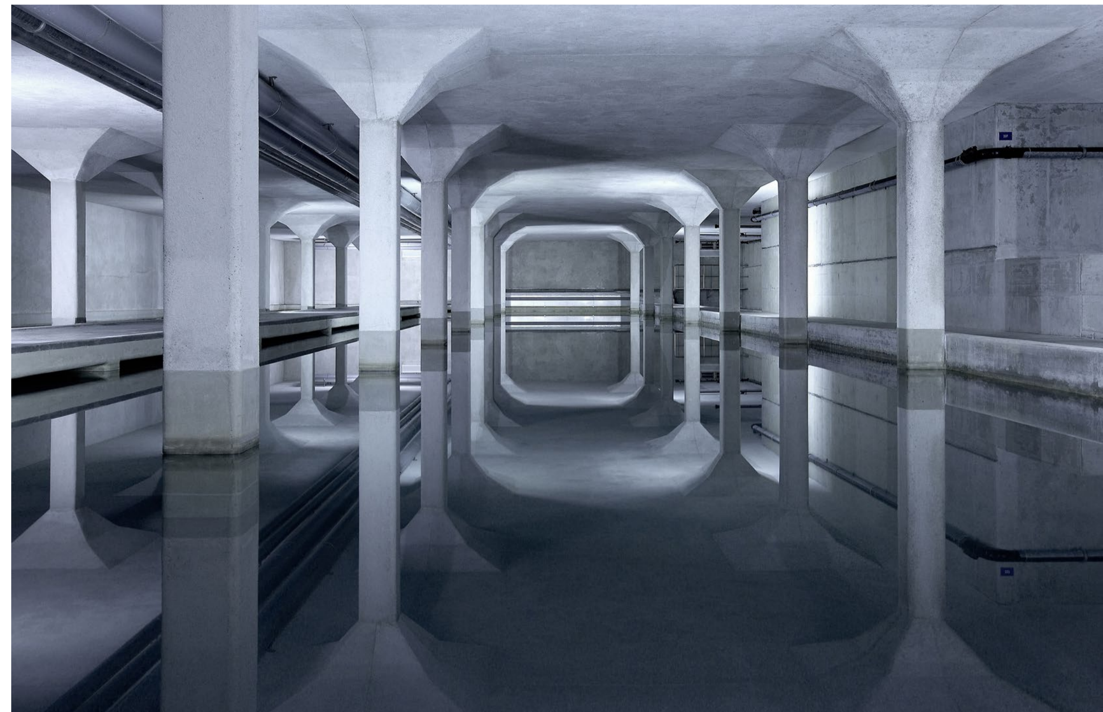
Fische als Vorkoster: Das Wasser, das im Seewasserkraftwerk Lengg aufbereitet wird, wird aus einer Tiefe von 32 Metern geholt. Im Werk befindet sich auch eine Fischestanlage, wo Forellen gegen den Trinkwasserstrom schwimmen und bei einer Verunreinigung elektronisch einen Alarm auslösen. Seit der Typhusepidemie von 1884 bezieht die Stadt Zürich ihr Trinkwasser nicht mehr aus der Limmat, sondern verwendet Seewasser.
