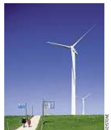
Windturbinen bei St. Imier.
