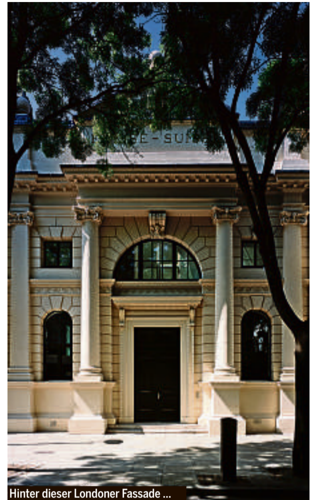
Hinter dieser Londoner Fassade ...
