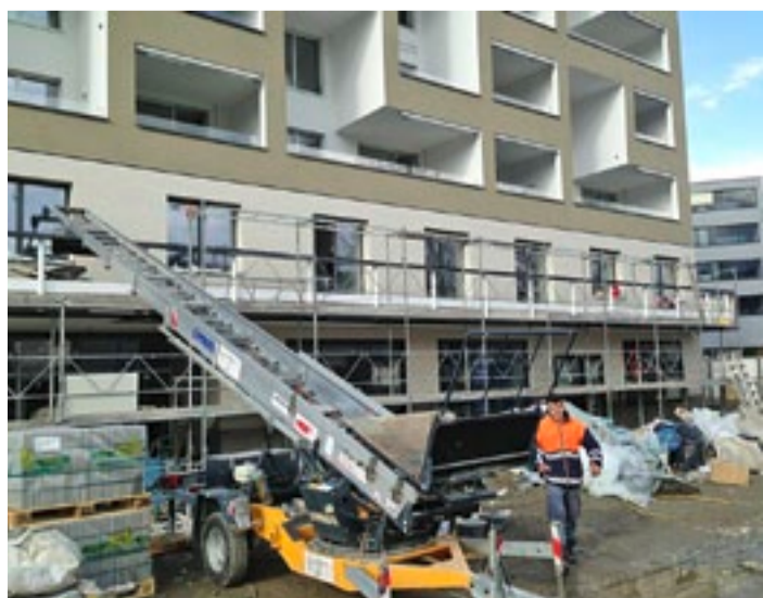
Eine Baustelle für Ideen bleibt die Ladenkirche, auch wenn sie fertig ist
